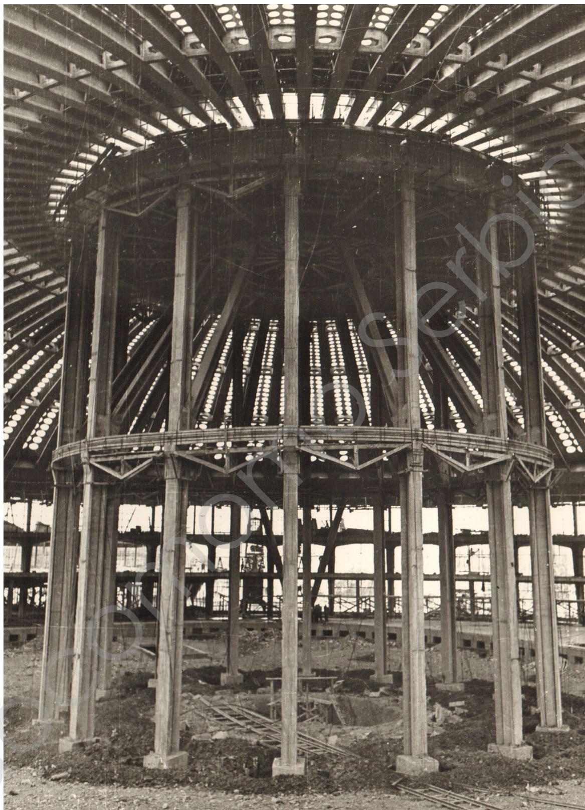
Слика 15: помоћна конструкција од бетона за монтажу крова Хале 1 непосредно пре уклањања. Аутор непознат, око 1956. године. Извор: фото документација КМГ Трудбеник, Музеј науке и технике, Београд.
