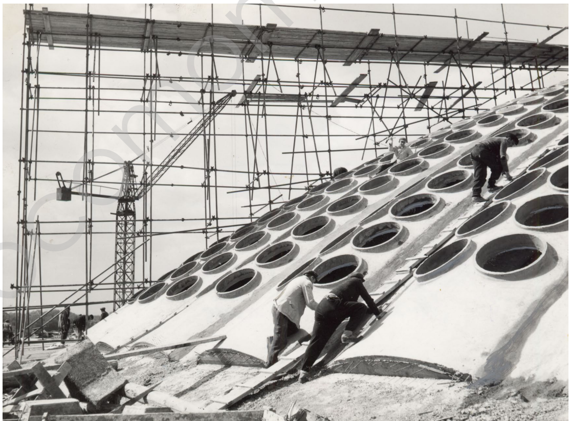
Слика 12: Монтажа и монолитизација крова Хале 1. Аутор непознат, око 1956. године. Извор: колекција Милоша Јуришића.
