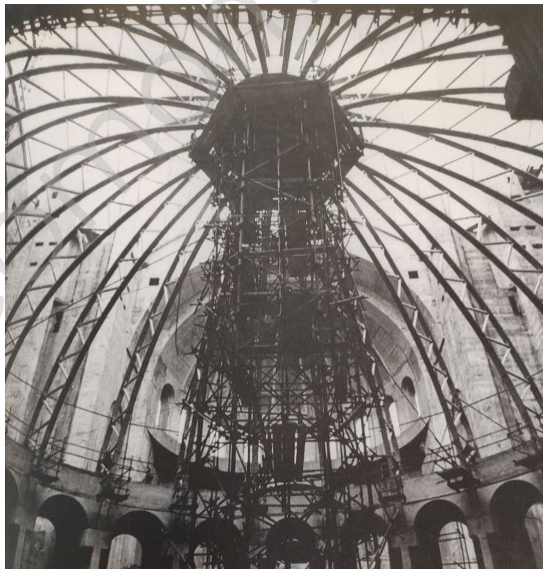
Слика 10: монтажа префабрикованих бетонских елемената за централну куполу храма Светог Саве у Београду, Петар Оторанов, 1989.
