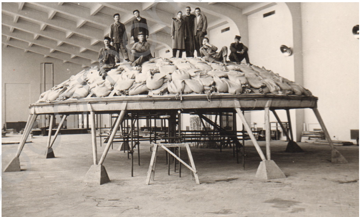
Слика 6: опитни модел Хале 1 под оптерећењем P=200 \text{ kg/m}^2 , 1955. година. Извор: „75 година Института за испитивање материјала“, с.22.
